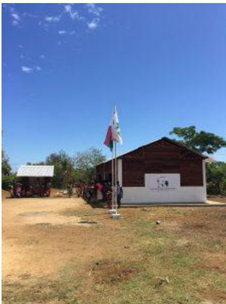
Realizzazione scuola – Villaggio di Antanfianambitry – 2017
