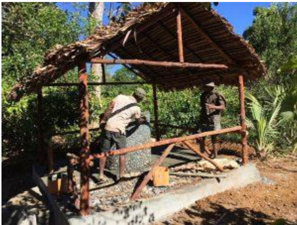
Realizzazione pozzo Villaggio di Andrianankonko anno 2017
